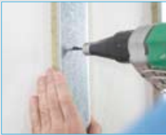
5. Stolperne placeres med en indbyrdes afstand på 550 mm og fastgøres med skrue (5,5 x 60 mm og rawplugs) pr. 600 mm lodret.
