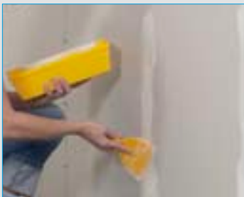
9. Ønskes samlingerne spartlet til en plan flade anvendes Knauf Uniflott. Forbrug ca. 300 g/m 2 .
