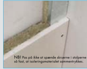
4. Første stolpe placeres tæt til den tilstødende væg og fastskrues. (Hvis begge vægge isoleres, se detalje A.
