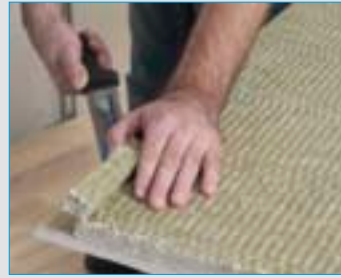
3. Ved start eller afslutning tilskæres isoleringsmaterialet, så det passer til stolpen. Brug en kniv eller fintandet sav.
