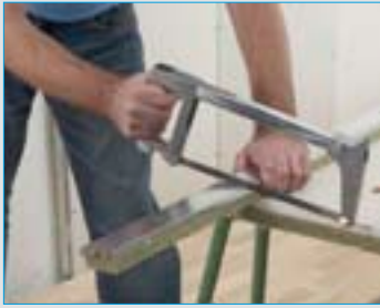
1. Isoleringsstolpen tilskæres med en nedstryger.
