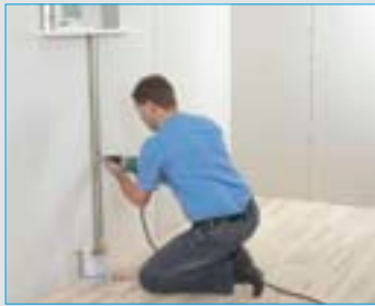
6. Elementet fastgøres med skrue RA 25 med en afstand på 200 mm. Brug en skruemaskine eller en boremaskine med bits.
