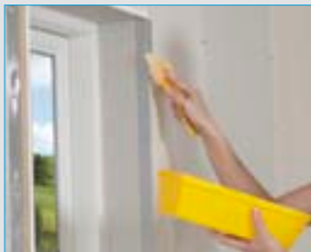
10. Hjørnebeskytter spartles på samme vis som gipspladerne. Vi anbefaler minimum 300 mm bred spartling ud fra hjørnebeskytteren.
