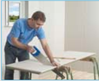
2. Elementerne tilskæres med en fintandet sav. Sav fra forsiden. Skær ud for vinduer og døre inden monteringen.
