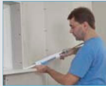
7. Efter montagen tætnes med acrylfugemasse mellem elementet og de tilstødende flader.
