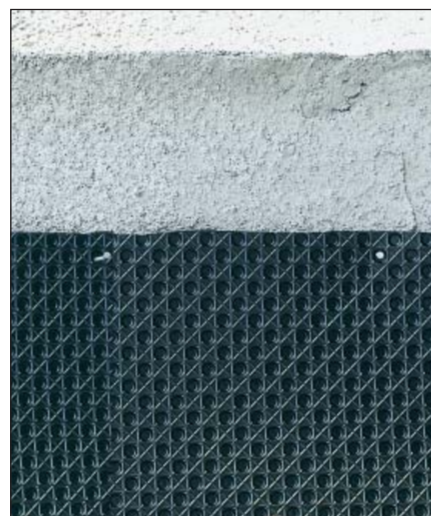
Icopal Universal fastgøres til ydermuren med specielle "propsøm", som er tilpasset knasterne. De sikrer, at pladen ikke trækkes ned af jordsætninger.
